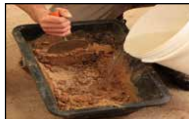
Étape 2 - préparation et humidification de l'enduit (spatule ou malaxeur)
